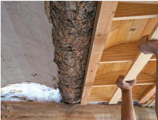
Reparación de un revoltón de yeso perdido de un forjado con molde de madera y yeso líquido vertido por la parte superior, según la tradición local, para garantizar su compatibilidad física, química, material y estructural con el resto del forjado histórico todavía existente, en Sesga (Valencia) (foto: Vegas & Mileto).
