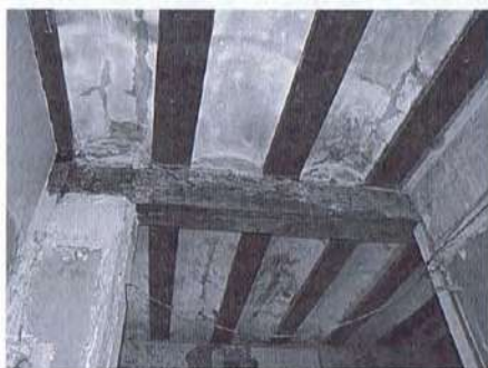
Fig. 3. Forjado de vigas de madera y revoltones situado en la primera planta de edificio de viviendas situado en Calle Maldonado número 33 (siglo XVI).
