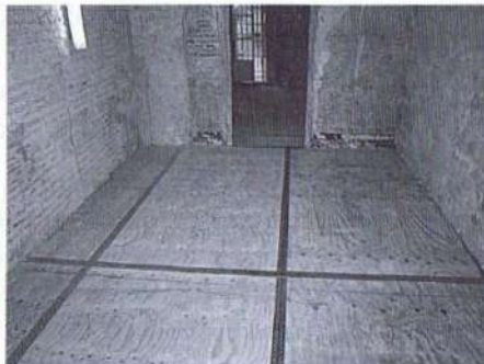
Fig. 10. Refuerzo del forjado del edificio realizado con capa de compresión de madera.
