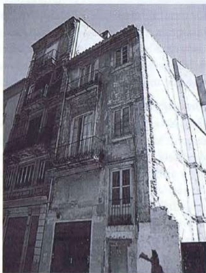
Fig. 2. Fachada del edificio de viviendas situado en Calle Maldonado número 33, antes de la restauración.
