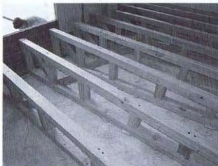
Fig. 11. Refuerzo de las vigas del forjado de la tercera planta realizado con costillas compuestas de madera.
