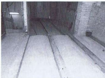
Fig. 9. Forjado de vigas y revoltones con el refuerzo de las vigas realizado con costillas de madera.
