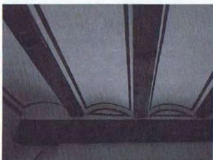
Fig. 14. Forjado de vigas de madera y revoltones con esgrafiados tras la restauración.
