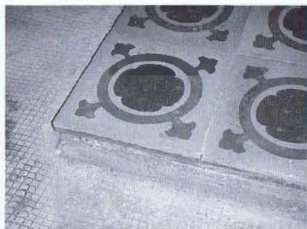
Fig. 12. Recolocación in situ de los pavimentos hidráulicos originales del edificio.
