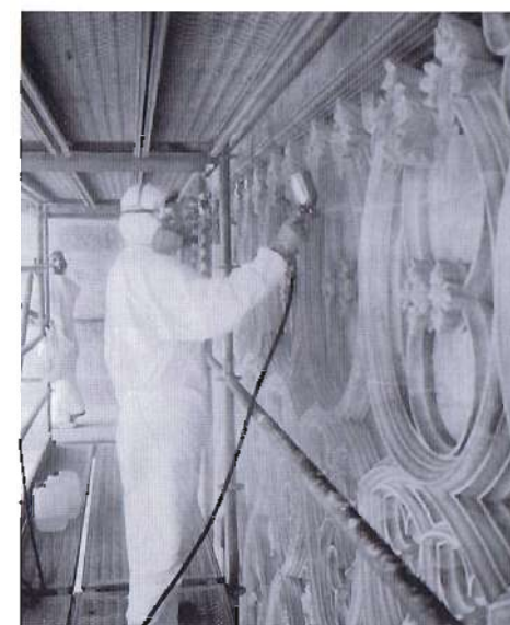
Una fase della pulitura degli elementi decorativi del fronte principale.
