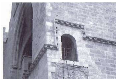
Paramento lapideo in cui sono chiaramente visibili gli interventi di integrazione del paramento realizzati durante il restauro dell'inizio del XIX secolo.
