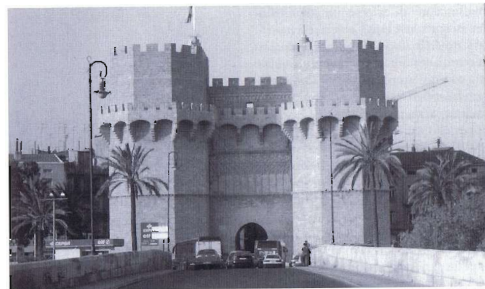
Le torri di Serranos dopo l'intervento di pulitura e consolidamento.
