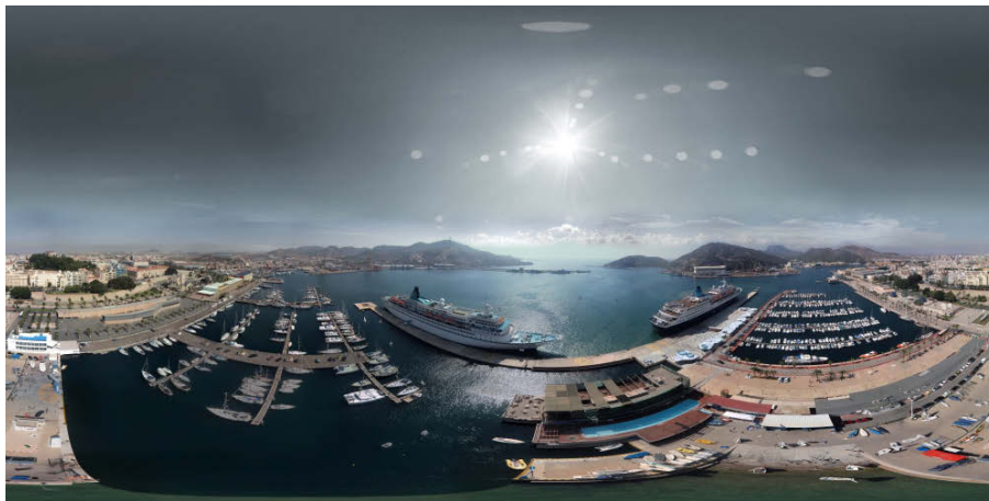
Fig. 2 Terminal de cruceros – Puerto de Cartagena
