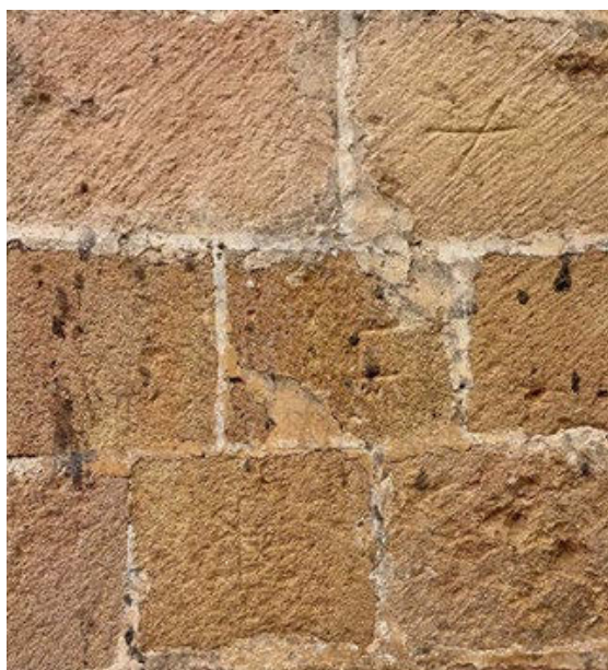
Fig. 2 Vista en detalle de la sillería en donde es posible apreciar diferentes marcas de cantero
