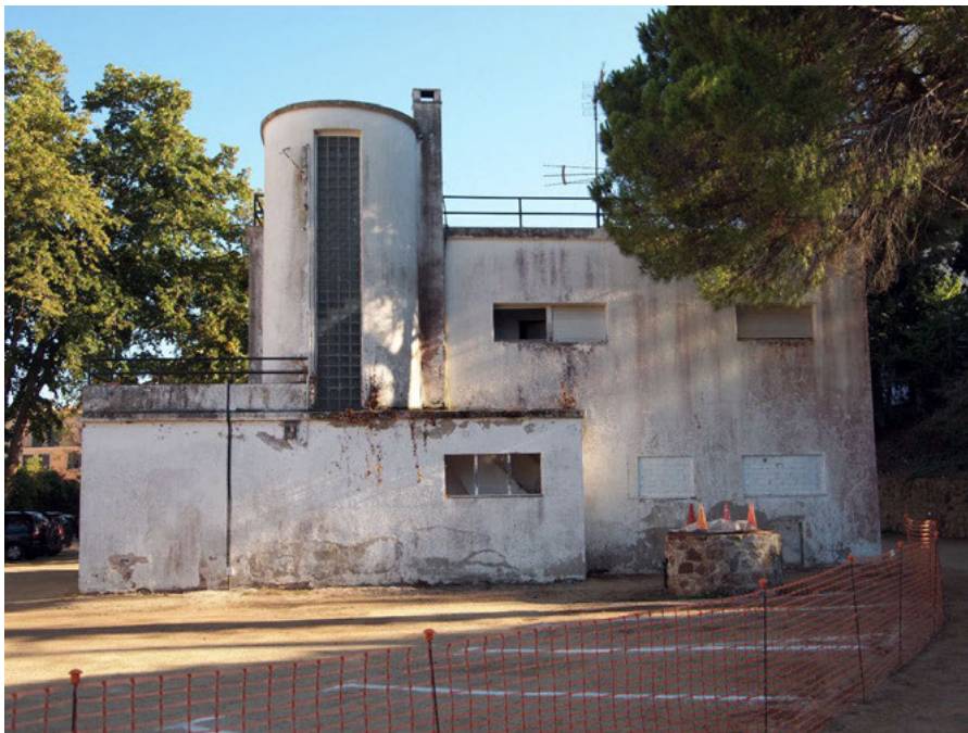
Fig. 4 Imagen de la fachada norte, con el cilindro como elemento principal y articulador de las distintas geometrías
