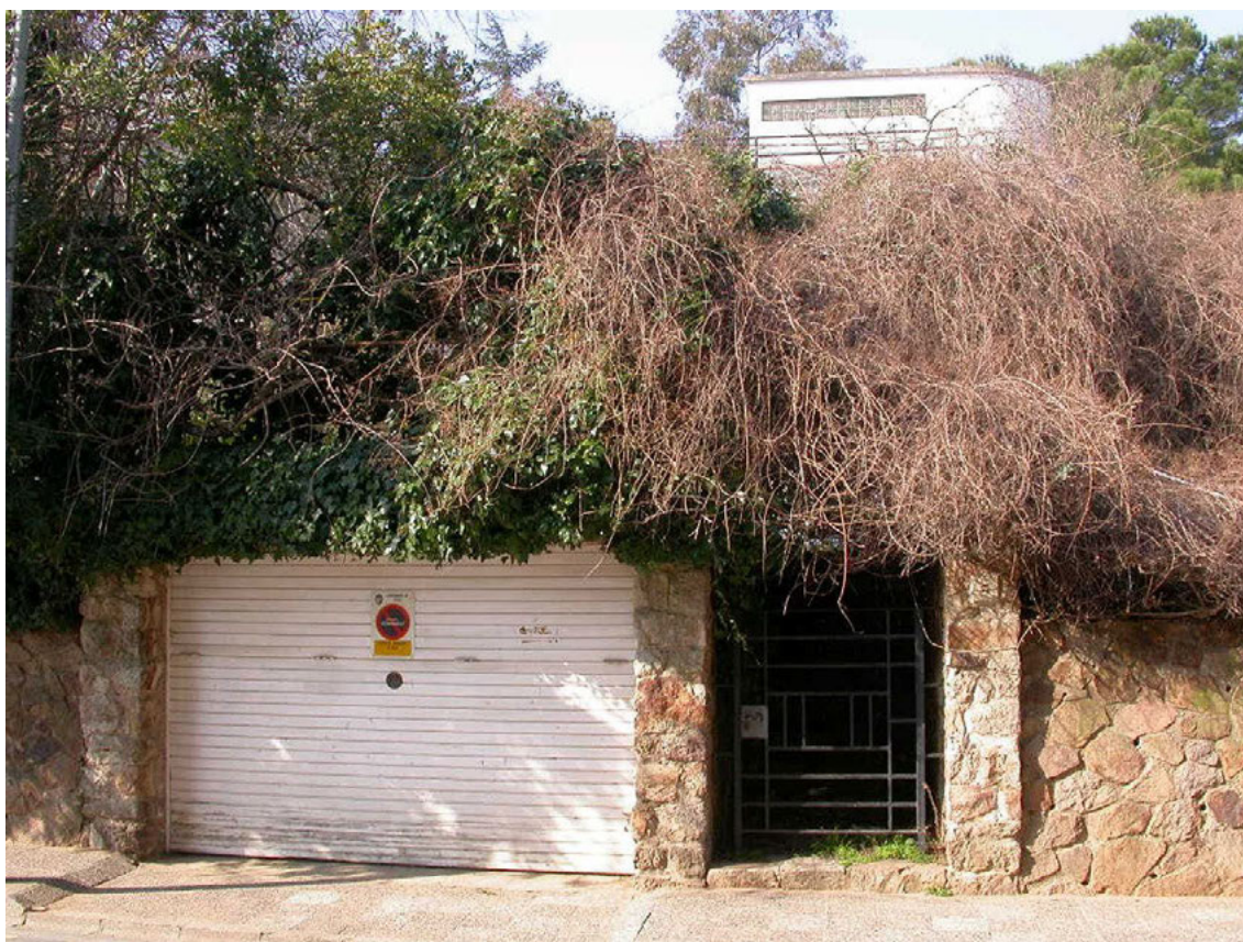
Fig. 1 Imagen de la casa Acerbi vista desde la calle hace 15 años, cuando estaba abandonada. Xavier Llobet. Arquitecto
