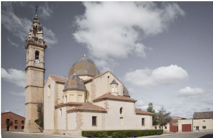
Fig. 1 Iglesia de Molacillos (Zamora). Los 256 habitantes de este pueblo ven peligrar su iglesia debido a los numerosos derrumbes que se están sucediendo, siendo incluida en 2021 en la Lista Roja del patrimonio en peligro. 2019
