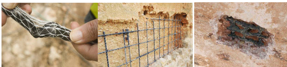
Fig. 3 Proceso de reconstrucción con hormigón de cal + malla de fibra de vidrio + fioccos de fibra de carbono. Mainel intervención arquitectura SL (2021)
