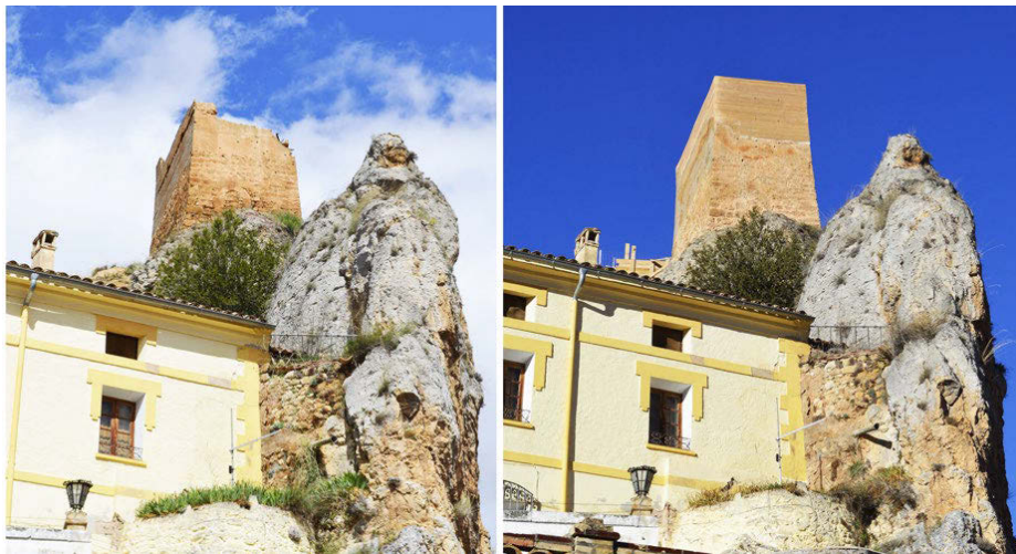
Fig. 2 Estado inicial y estado final del exterior de la torre del Mediodía. Mainel intervención arquitectura SL (2021)
