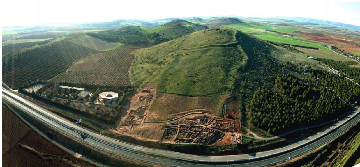
Fig. 6 Vista panorámica del Cerro de las Cabezas y las instalaciones anexas, en la parte izquierda de la imagen.
