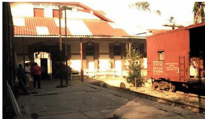
Fig. 3 Fachada posterior de la estación. Archivo de investigación del autor (2018)
