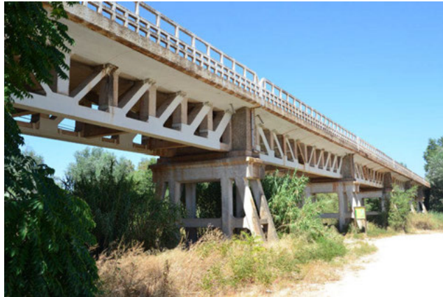
Fig. 1 Viaducto sobre el río Guadalquivir en Villanueva de la Reina (Jaén). Compuesto por 11 tramos rectos de 20 m de luz formados por vigas trianguladas de hormigón armado. Diseñado por F. Navarro en 1917
