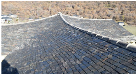
Fig. 1 Vista de la nave central y el crucero desde la espadaña
