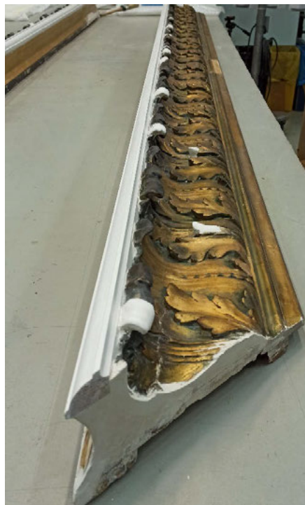
Fig. 5 Reconstrucción y estucado de la moldura repuesta
