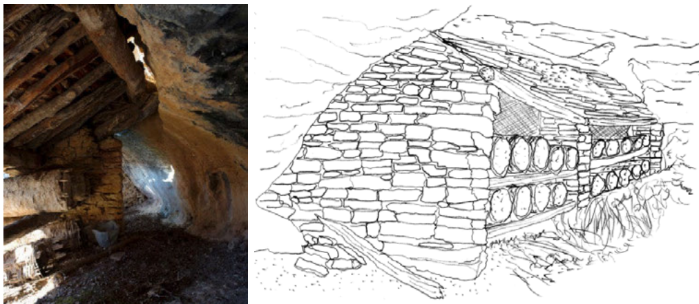
Fig. 6 Arnal contra farallón rocoso en Betorz, municipio de Bércabo
