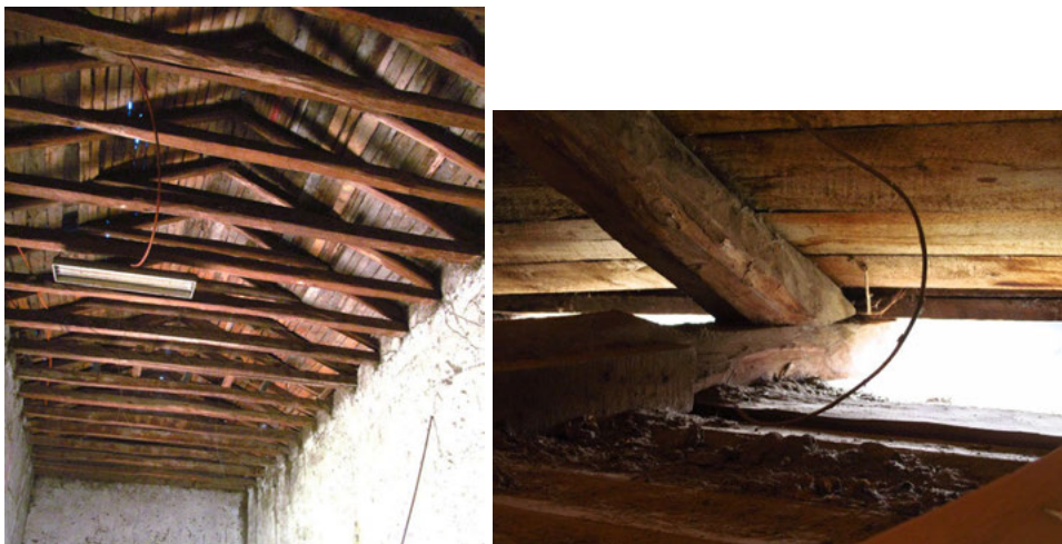
Fig. 4 Tijerales de cubierta sobre muros de adobe y detalle de apoyo sobre cadena superior en coronación de muro, Casona Quilapilún. Contreras y Jofré, 2016
