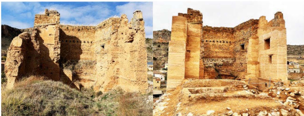
Fig. 6 Interior del espacio central hacia el volumen principal antes y después de la intervención. Mainel intervención arquitectura SL (2021)
