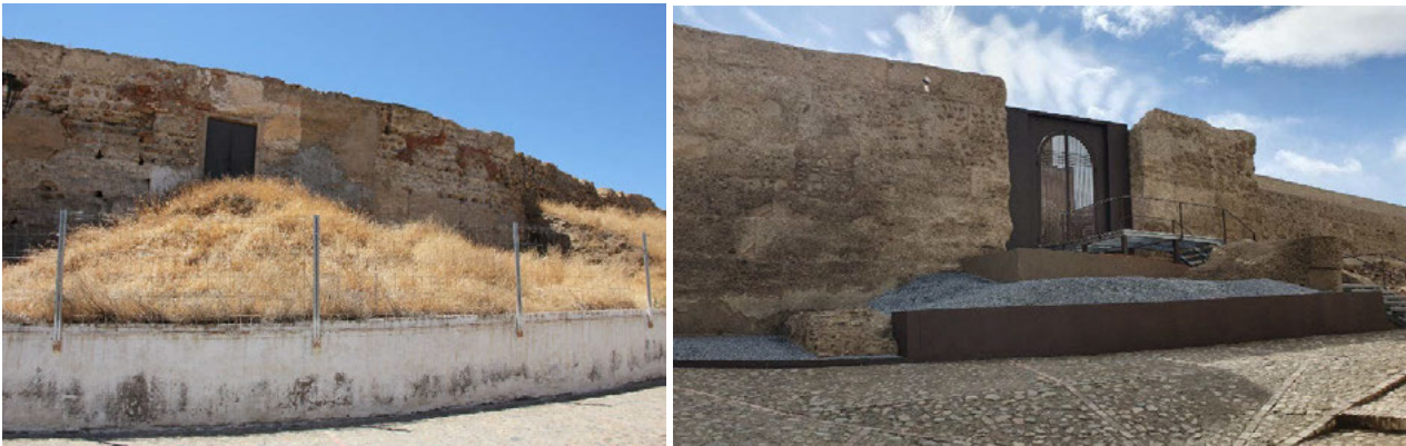
Fig. 1 Estado previo y final de la intervención en la puerta norte de la alcazaba de Guadix
