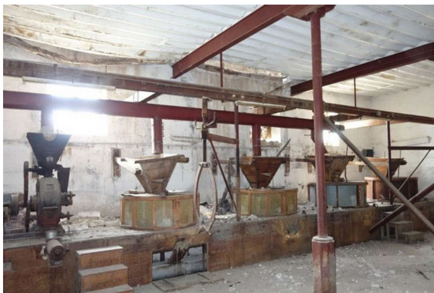
Fig. 2 Sala principal de molienda. 2021
