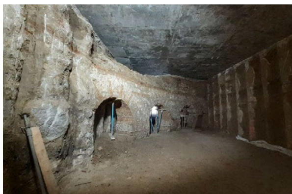
Fig. 4 Vista de los restos del muro que configuraba el paseo de ronda del Cuartel de San Gil aparecidos encajados en el túnel de salida a la calle Ferraz (Madrid) y Fig. 5. Detalle de la estructura en su actual ubicación durante su proceso de reintegración y restauración. Fuente: Miguel Ángel López Marcos.
