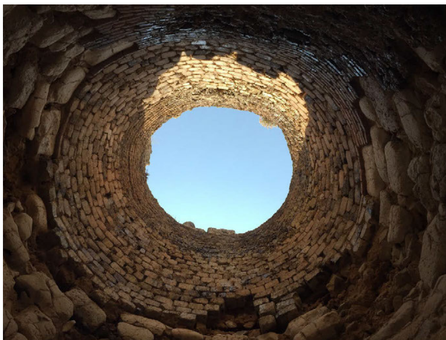
Fig. 6 Interior de la chimenea de un horno de cal de Cornicabra. Martín de Torres, D. (2019)
