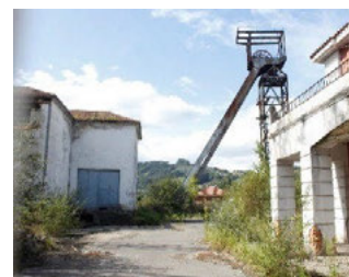
Fig. 3 Estado Actual de La Camocha, edificios principales y castillete. (2020)
