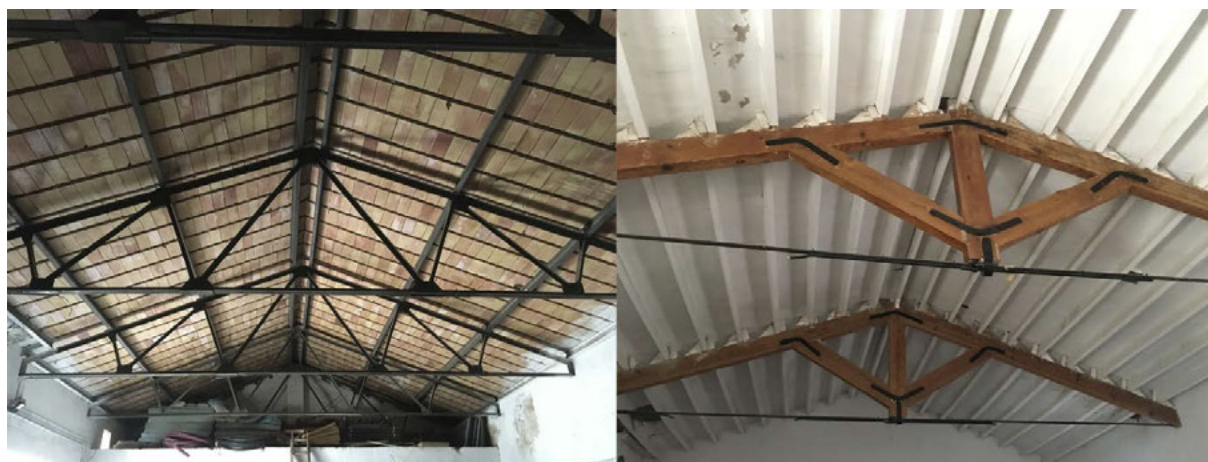
Fig. 2 Cerchas metálicas en la nave oeste y cerchas de madera en la nave este configurando los espacios de diáfanos de mayor tamaño
