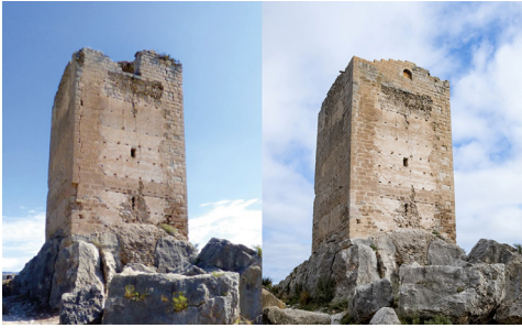
Fig. 10- La fachada meridional de la torre antes y después de la restauración (Vegas & Mileto, 2020)
