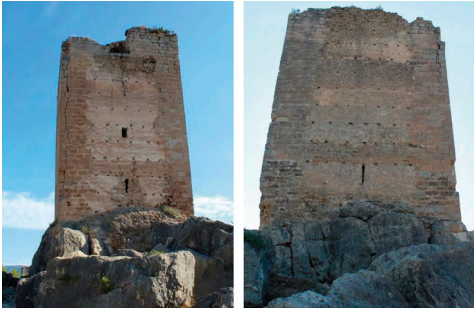
Fig. 6- Fachadas sur y oeste de la Torre del Homenaje (Vegas & Mileto, 2018)
