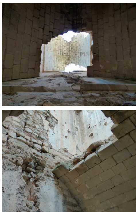
Fig. 4- Vista general y de detalle de las bóvedas interiores de la Torre del Homenaje (Vegas & Mileto, 2018)
