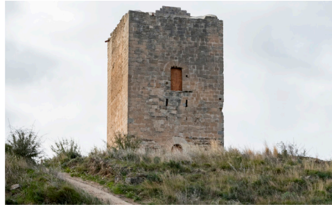
Fig. 11- La fachada principal de la torre tras de la restauración (Vegas y Mileto, 2020)
