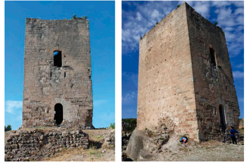
Fig. 2- Fachadas norte y este de la Torre del Homenaje (Vegas & Mileto, 2018)
