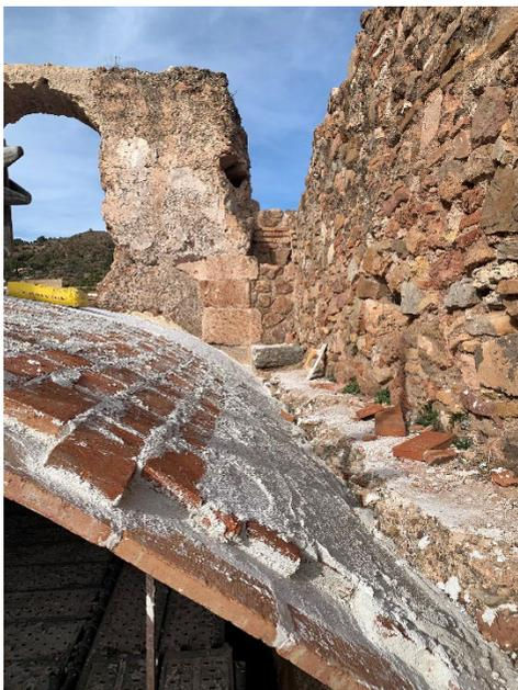
Fig. 10- Construcción de la bóveda tabicada en la sala este. En la imagen se aprecian las dos capas de ladrillos con las que se conforma la bóveda (Autores: Vegas y Mileto).
