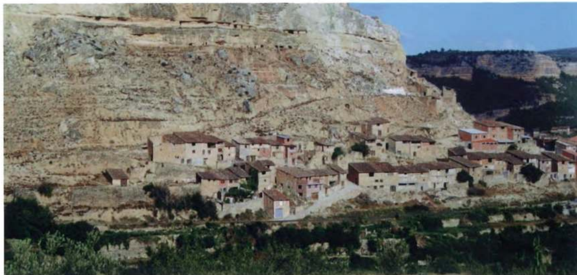
Ademuz. Integración de las construcciones en la ladera del cerro
