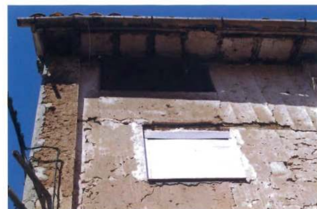
Carpintería de aluminio en muro tradicional
