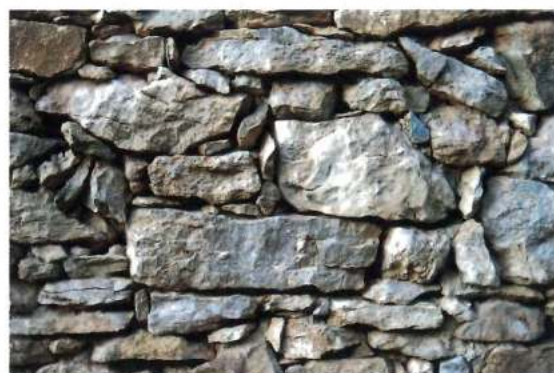
32. Sesga. Bloques de dolomías y calizas muy resistentes
