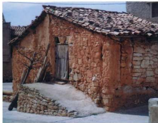
Mas del Olmo. Casa con cubo de mampostería entre machones, cuya escalera exterior ha sido sustituida por una rampa
