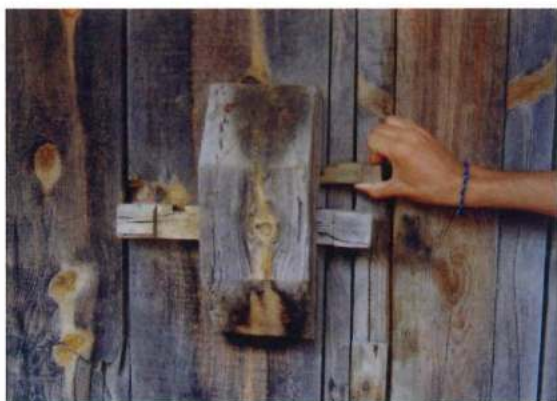
Sesga. Proceso de apertura de un cerrojo de madera con ayuda de su llave también de madera
