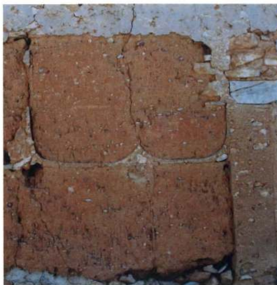
Torrebaja. Muros de tierra cruda
