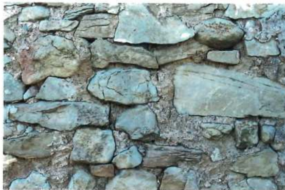
24 y 25. Arroyo del Cerezo. Dolomías, calizas y areniscas compactas
