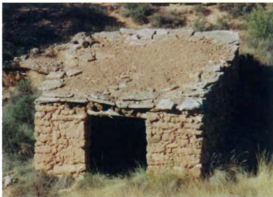
Mas del Olmo. Construcción auxiliar completamente techada con lajas de piedra. (fotografía de N. Espinosa)
