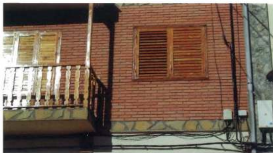
Aplacados de lajas sobre las bandas del forjado combinado con ladrillo caravista
