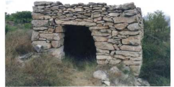
Carretera de Val de la Sabina a Sesga. Exterior de un refugio de piedra en seco
