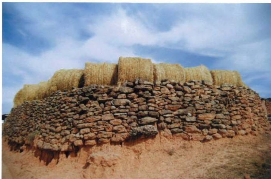
Mas del Olmo. Muro de piedra en seco (fotografía de N. Espinosa)
