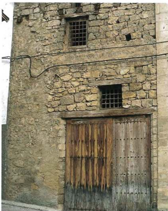
Vallanca. Fábrica de sillarejo
