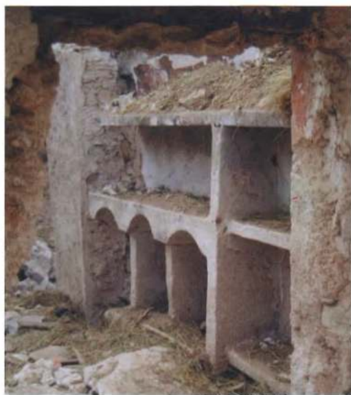
Negrón. Vaseras de una casa demolida
