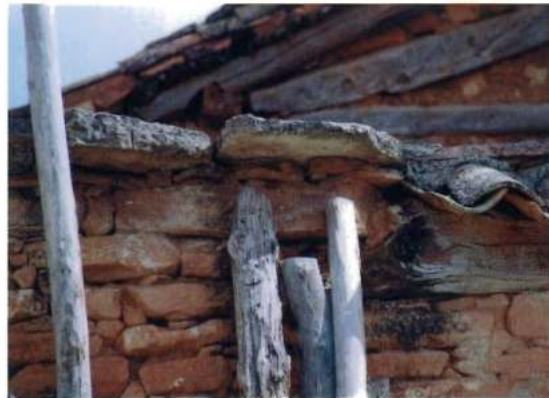
Mas del Olmo. Convivencia de las lajas de piedra y las tejas árabes en dos cubiertas adyacentes
