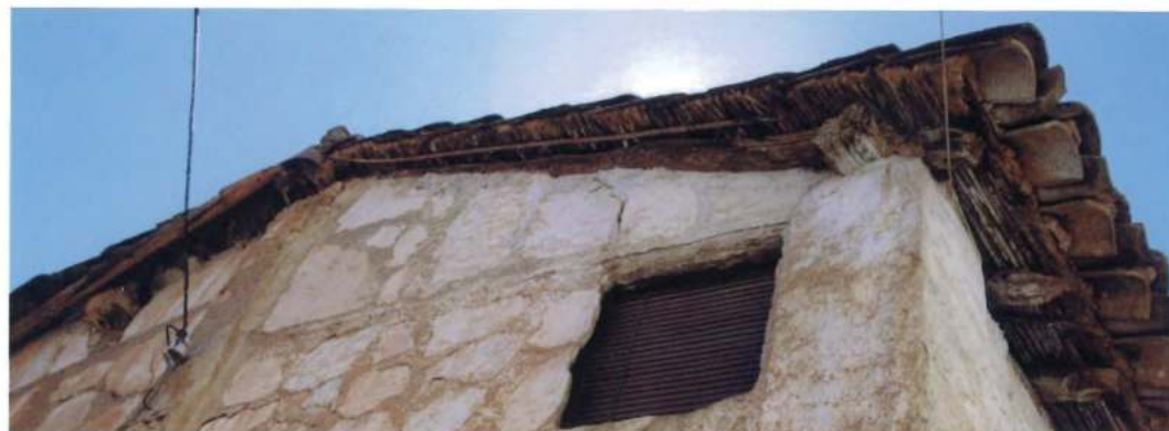
Ademuz. Tabique de lajas de piedra recibido con mortero de yeso en el cerramiento superior de una casa
