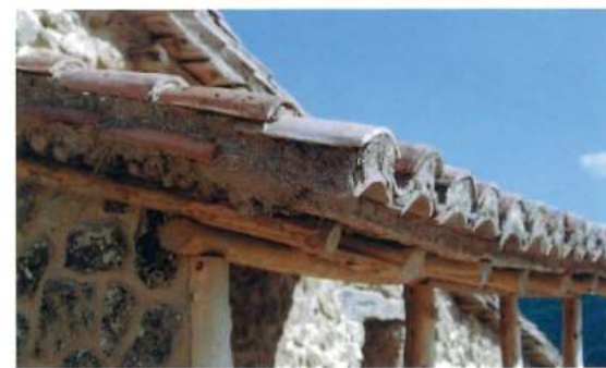
Intento de recuperación de antiguas técnicas de construcción en la rehabilitación de una tejería de la Puebla de San Miguel
