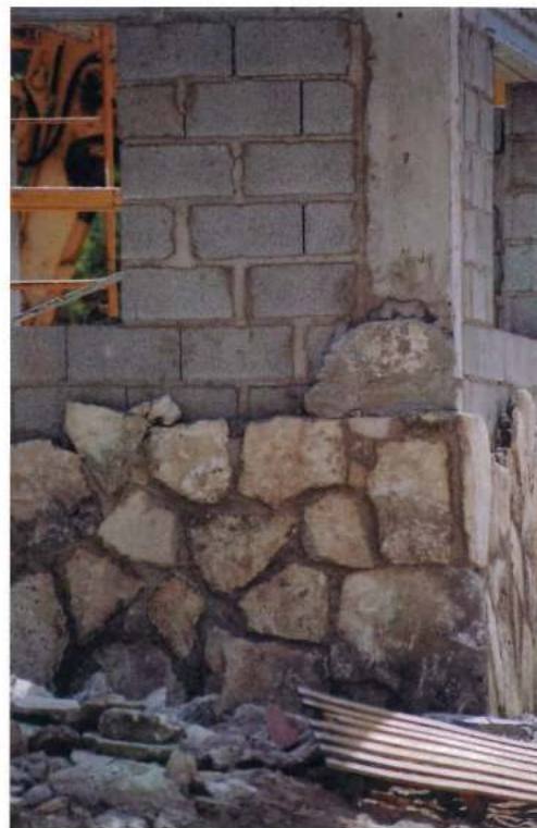
Disfraz de piedra para una estructura de hormigón
