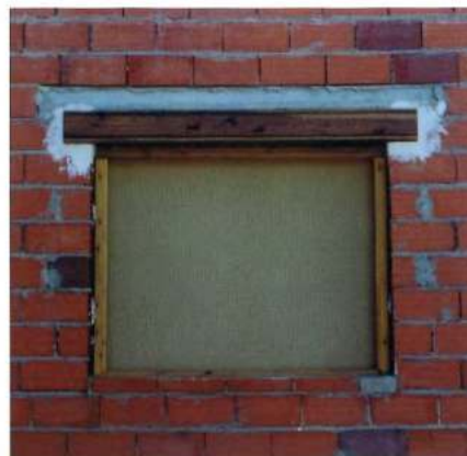
Dintel de hormigón forrado de madera
