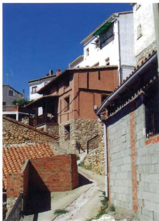
Intervenciones de rehabilitación de casas en Castielfabib
