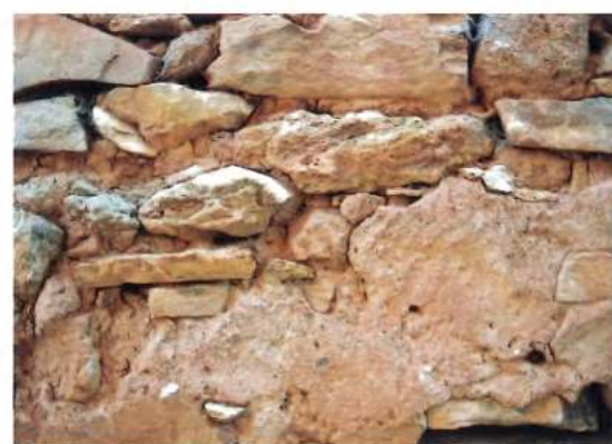
36. Puebla de San Miguel. Muros contruidos con areniscas revestidos de aljez
