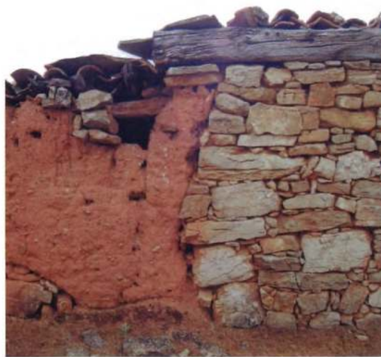
Sesga. Encuentro de muro de tapial y muro de mampostería careada
