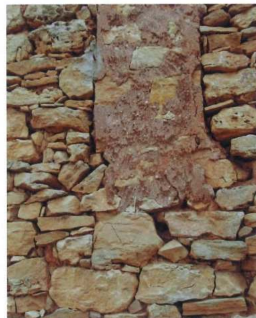
Sesga. Detalle de machón de yeso naciendo de un muro de mampostería
