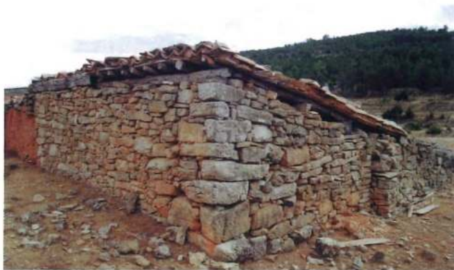
Sesga. Muro de mampostería trabado en la esquina con ayuda de grandes sillares
