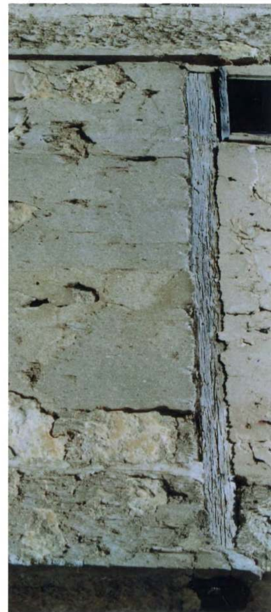
Vallanca. Tabique de lajas encofrado a una cara
