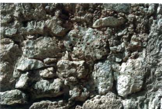
27. Vallanca. Material poroso empleado extensamente
