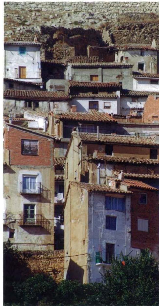
Ademuz. Construcciones en la pendiente
