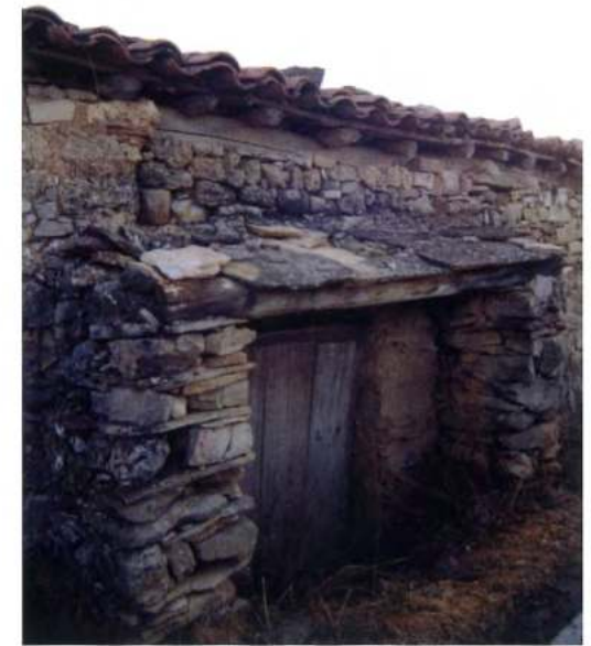
Arroyo del cerezo. Cubierta de lajas de piedra sobre un porche de entrada
