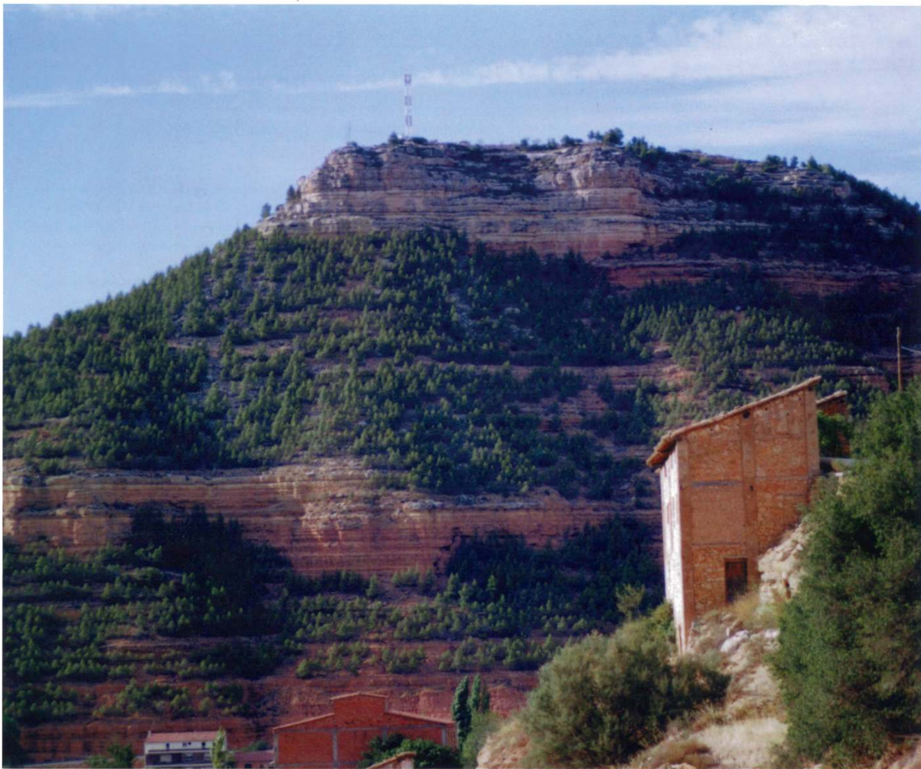
Construcción acabalgada en la pendiente, cerca de Ademuz
