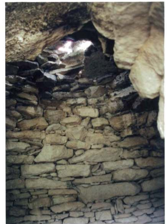
Carretera de Val de la Sabina a Sesga. Interior de un refugio de piedra en seco
