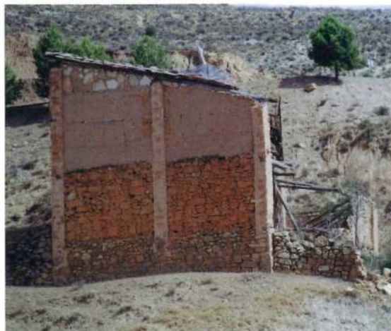
Val de la Sabina. Cerramientos de mampostería y tabiques de lajas de piedra encofrados a una cara o vistos
