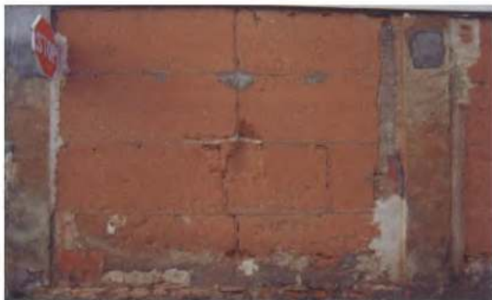
Torreba. Muros de tapial con brencas realizados fundamentalmente con tierra
