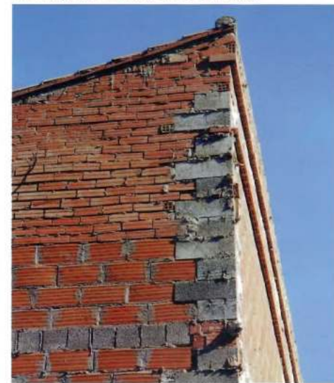
Aparejos reinventados de la nueva vivienda inmediata
