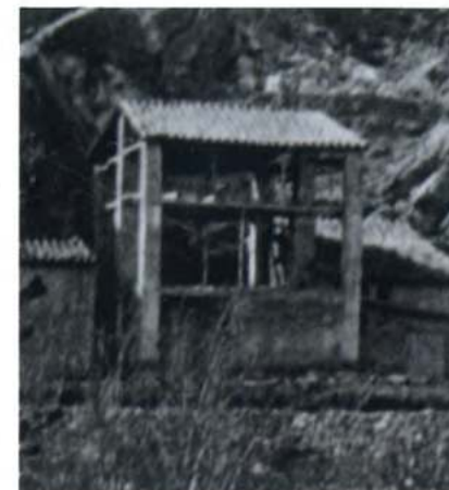
Castielfabib, 1917. Casa en construcción. (fotografía de I.A.A.H.)
