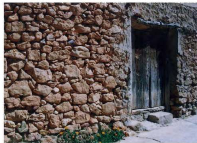
Ejemplos de fábricas de mampostería con piedras de diversa extracción
