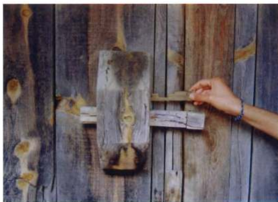
Sesga. Proceso de apertura de un cerrojo de madera con ayuda de su llave también de madera
