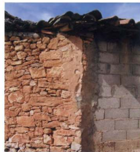
Reparación de construcciones auxiliares con la materia prima inmediata de la actualidad
