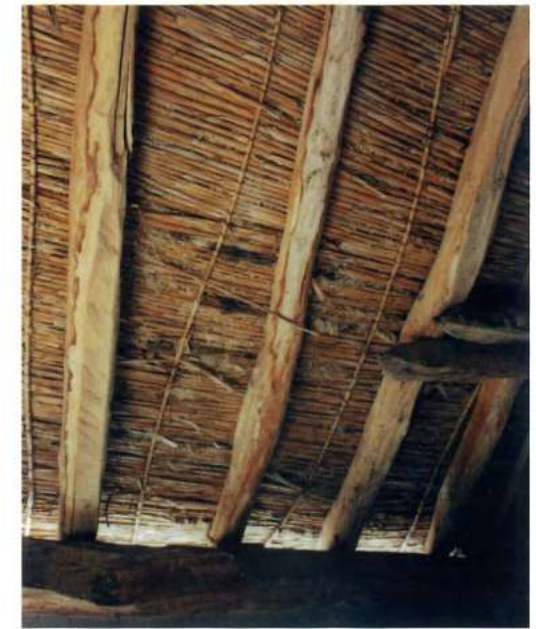
Arroyo del cerezo. Cubierta formada por rollizos de madera, cañizo, capa de barro y teja árabe
