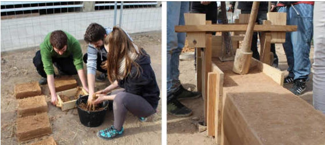
Fig. 3. Imagen de los talleres de fabricación de adobes y construcción con tapia.
