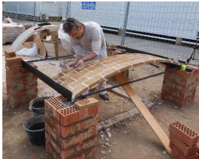
Figura 2. Construcción de una bóveda de cañón de BTC con motivo de la preparación de la colaboración de la UPV en el pabellón “Beyond bending” de OBD (Ochsendorf, Block & DeJong) en la Bienal de Arquitectura de Venecia 2016 (Fotografía: S. Tomás Márquez)
