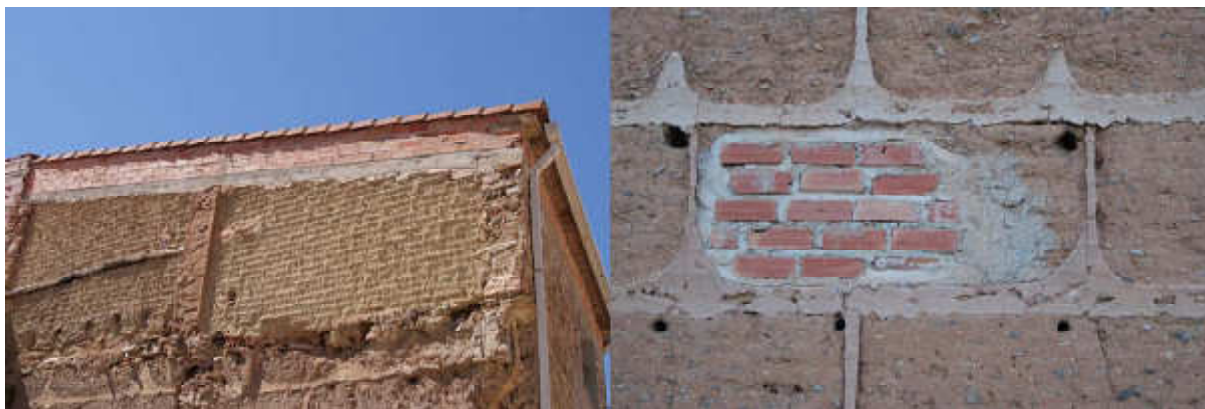
Figura 6. Nueva cubierta construida sobre el muro de adobes y mampostería en Torre las Arcas (Cuencas Mineras) y relleno de laguna en una tapia con brencas en Orrios (Comunidad de Teruel). Fuente: L. Villacampa
