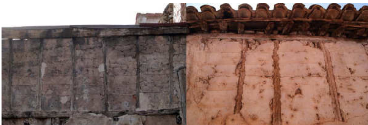
Figura 4. Entramados de madera con relleno con pared de mano encofrado a un lado en Moscardón y de tapiate en Gea de Albarracín (Sierra de Albarracín). Fuente: L. Villacampa
