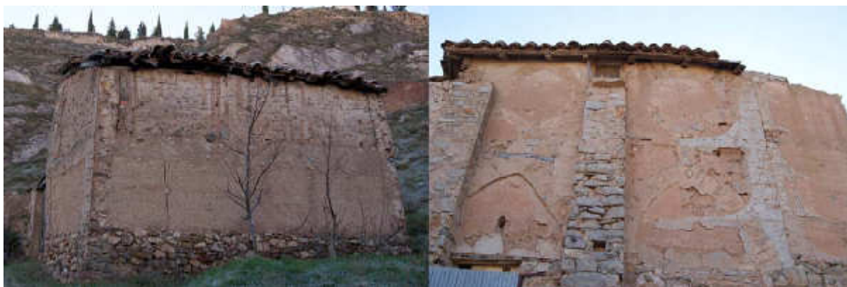
Figura 3. Edificio construido en tapia y tapiate en Montalbán (Cuencas Mineras) y de tapia con arcos de descarga en Argente (Comunidad de Teruel). Fuente: L. Villacampa
