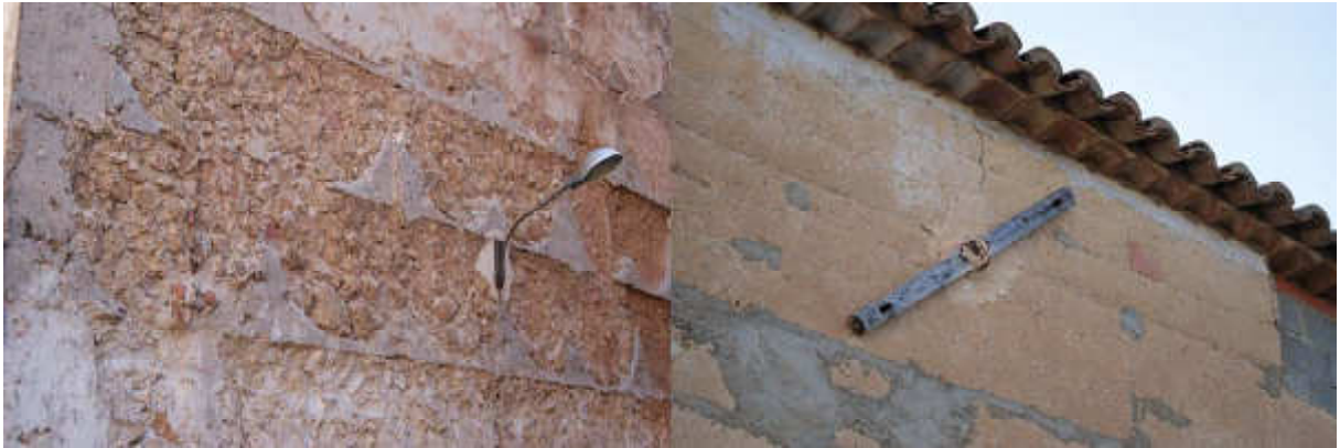
Figura 7. Tapia con brencas reparada con mampuestos cogidos con yeso en Martín del Río (Cuencas Mineras) y muro de tapia atirantado con un tirante que utiliza de sujeción un costal del tapial en Aguatón (Comunidad de Teruel). Fuente: L. Villacampa
