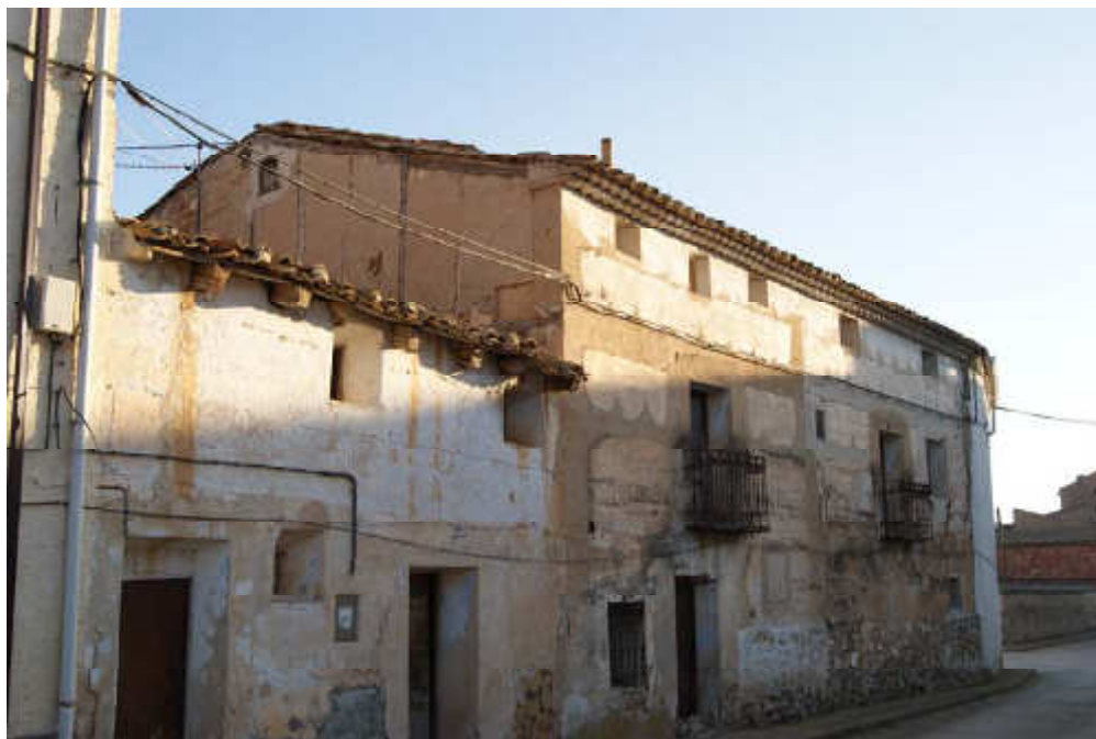
Figura 1. Conjunto de edificios tradicionales construidos con tierra. Torremocha, Comunidad de Teruel. Fuente: L. Villacampa
