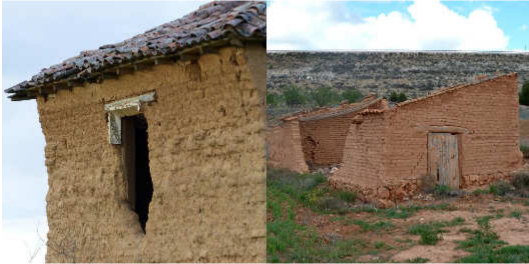
Figura 5. Lesiones derivadas de un inadecuado mantenimiento: 5a. Erosión de un muro de adobe en una construcción que ha perdido las carpinterías. Grajal de Campos, León. 5b. Pérdida de la cubierta y ruina de un edificio de adobe en Pozuel de Ariza, Zaragoza. Fuente: Fernando Vegas y Camilla Mileto.
