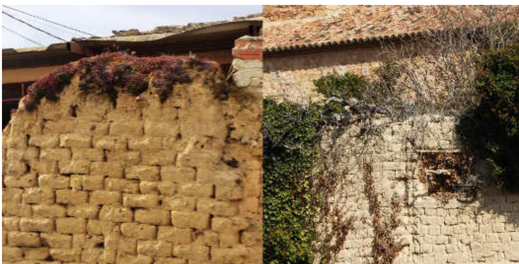
Figura 4. Desarrollo de vegetación en el entorno de un muro de adobe: 3a. Desarrollo de musgos en la coronación de un muro de adobe en Lagunilla de la Vega, Palencia. 3b. Desarrollo de vegetales superiores sobre un muro de adobe y crecimiento de árboles contra él. Godojos, Zaragoza. Fuente: Fernando Vegas y Camilla Mileto.
