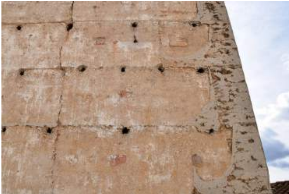
Figura 3. Detalle de una construcción tradicional ejecutada con la técnica de la tapia real con brencas y rafas de yeso careada con piedra, con un único mampuesto aislado en posición central por tapiada (Barrio de Benacacira, Chelva)
