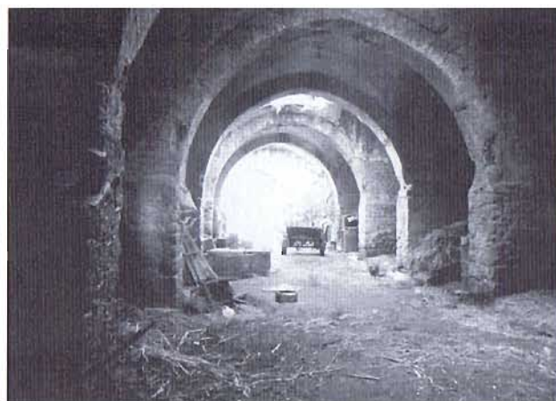
9. Estado del interior de una de las naves de las atarazanas
