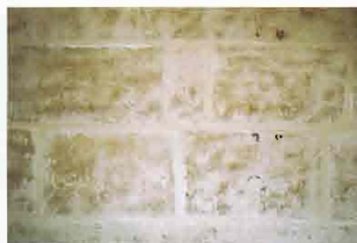
16. Aspecto final de las nuevas juntas
