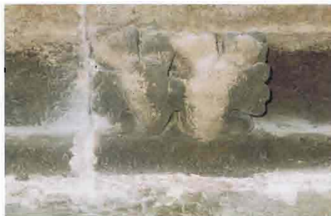
28 y 29. Fotografías de antes y después de la limpieza de los elementos decorativos de la faja perimetral
