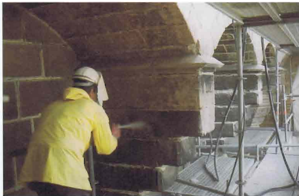
22. Limpieza de la zona con costra negra, situada debajo del adarve, con proyección de árido en húmedo.
