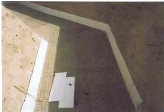
2. Capa de grava sobre la que se asentó la losa
