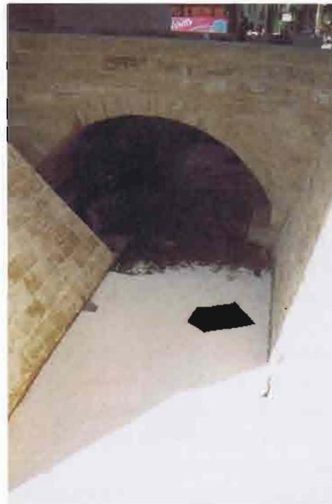
41. Colocación de la malla impermeabilizante
