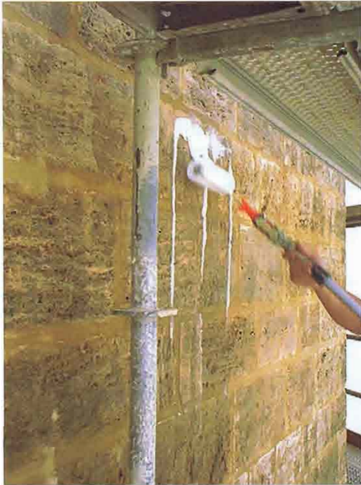
26. Aplicación del hidrofugante mediante rodillo
