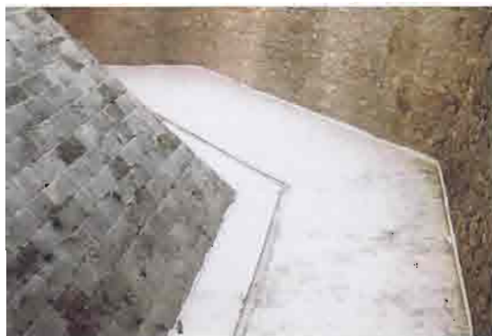
3. Losa de hormigón para regularizar la superficie del foso
