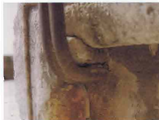
34. Anclaje de la barandilla a la piedra
