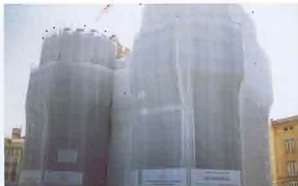
6. El andamio de la fachada norte de las Torres cubierto por la lona microperforada
