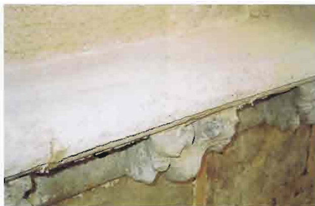
27. Realización de un plano inclinado con ayuda de mortero
