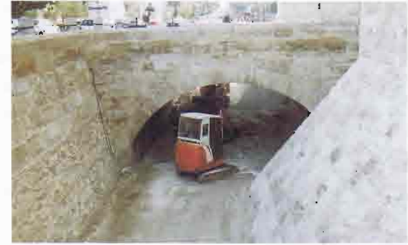
40. Eliminación de la losa en el foso
