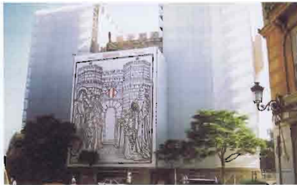
5. El andamio de la fachada sur de las Torres cubierto por la lona microperforada
