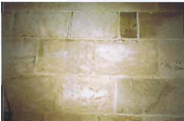
25. Consolidación de una zona pequeña de paramento de sillares
