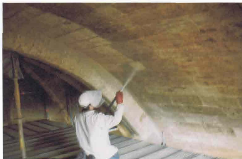
23. Limpieza de algunas zonas del interior con proyección de árido en húmedo
