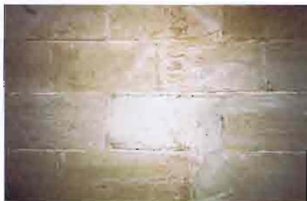
11. La junta se picó sólo hasta una profundidad limitada
