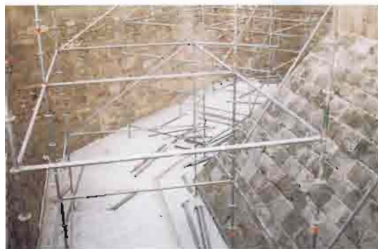
4. El montaje del andamio
