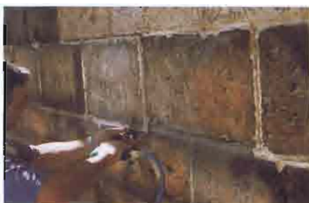
10. Herramienta mecánica para el repicado de las juntas
