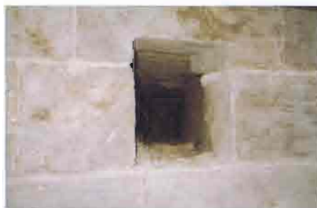
12 . Mechinal en el paramento exterior de la torre
