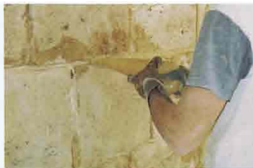
14. Rejuntado mediante manga de pastelero
