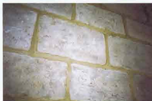
15. Secado de la junta
