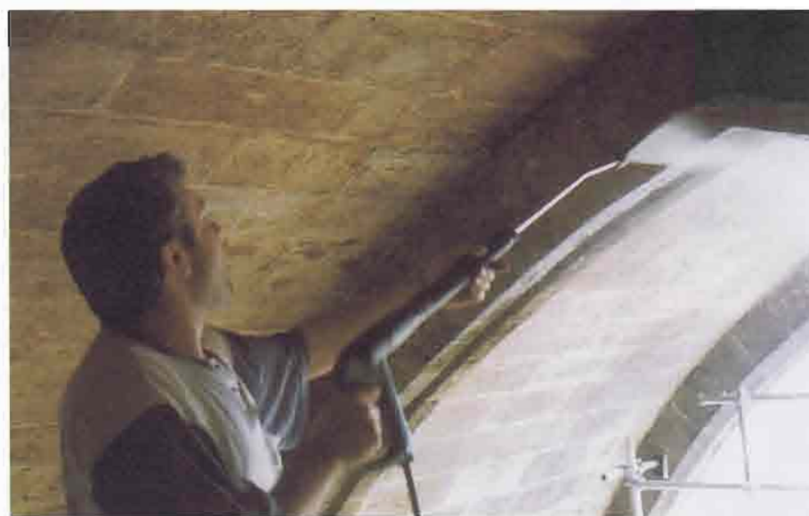
9. Limpieza con agua a baja presión
