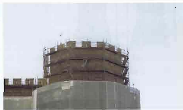
7. Retirada parcial de la lona para comprobar los resultados del trabajo
