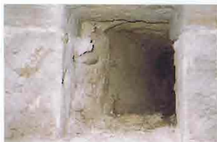
13. Mechinal en la torre de Levante
