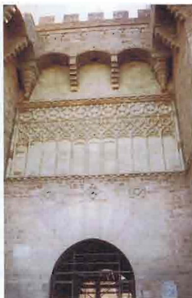
49 y 50. El cuerpo central con la tracería antes y después de los trabajos de limpieza.
