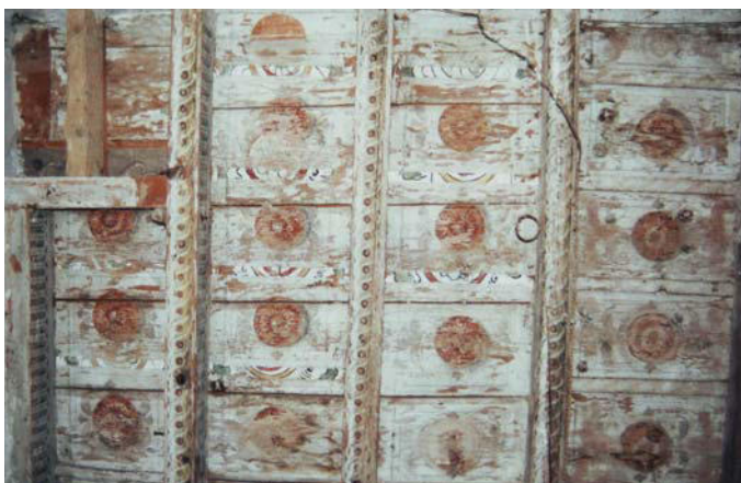
Planches d'un plafond à caissons polychrome qui présentent une double couche de peinture et les traces de leurs différentes positions par rapport à leur position initiale.
