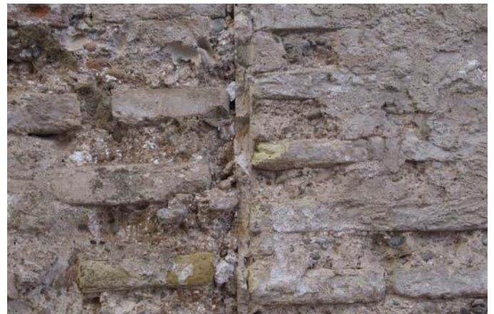
Le mortier indique que le mur de gauche s'adosse au mur de droite.
