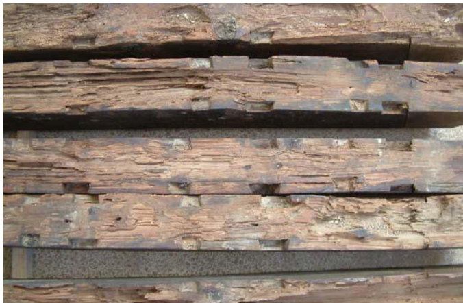
Pièces de bois d'un plafond à caissons réutilisées qui présentent deux types d'entailles différentes pour les appuis des saetinos (lattes de bois).
