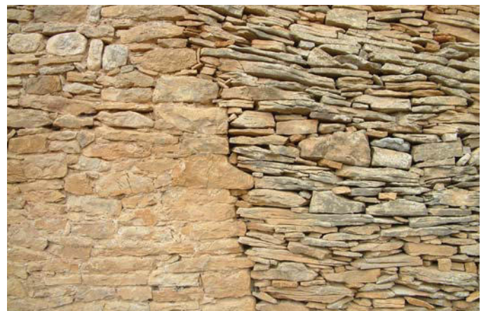
Relation stratigraphique s'adosse à / est adossé par (le mur de droite s'adosse au mur de gauche).
