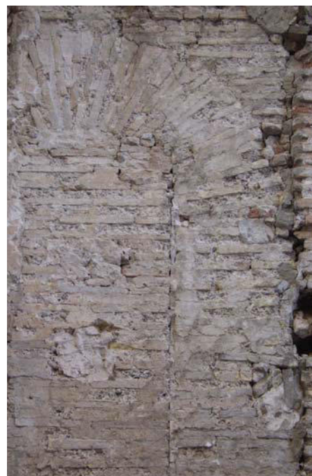
Relation stratigraphique remplit / est rempli par (le pisé remplit l'arc).
