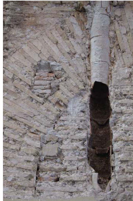
Relation stratigraphique coupe / est coupé par (le mur est coupé pour insérer la gouttière).
