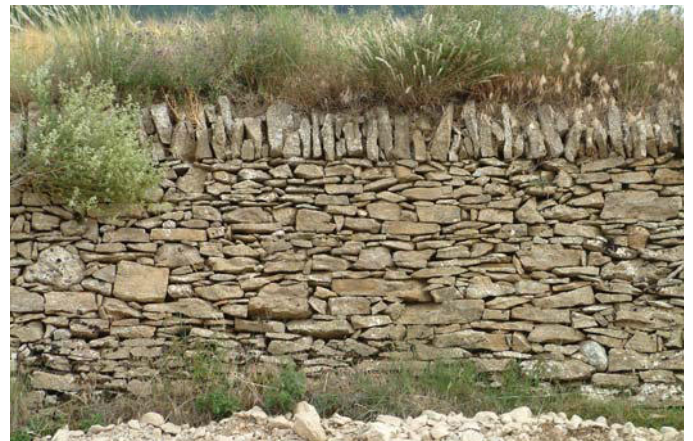
Relation stratigraphique se lie à (le mur de pierre sèche se lie à la partie supérieure construite à la même époque).
