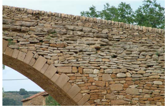
Unités stratigraphiques dans le pont de la Pobleta de San Miguel (Villafranca del Cid, province de Castellón, Espagne). Chaque unité stratigraphique se distingue par la technique constructive employée.
