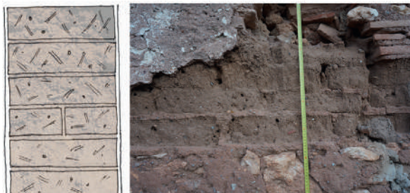
Abb. 6 Details einer Adobewand
