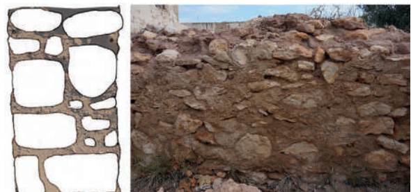
Abb. 8 Detail einer Lehmwand mit Mauerwerkverstärkung
