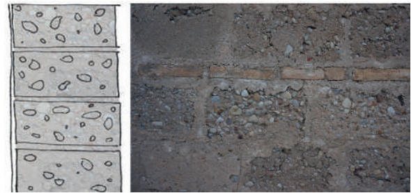
Abb. 7 Details einer Lehmwand mit stabilisierten Lehmsteinen
