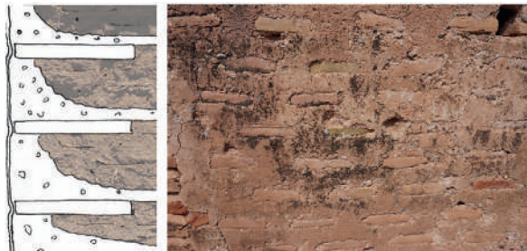
Abb. 3 Eine typische Hauswand in Valencia (Typ I)
