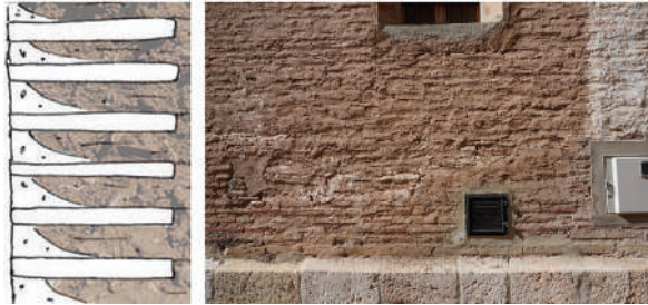
Abb. 5 Typ III einer Stampflehmwand in Valencia
