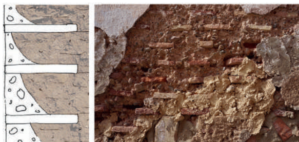
Abb. 4 Details einer typischen Stampflehmwand in Valencia (Typ II)
