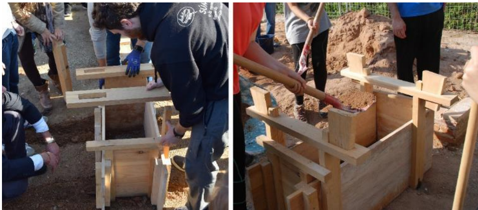
Fig. 2 Taller de construcción con tapia (Fuente: autores)
