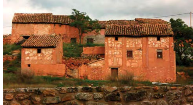
3 Conjunto de casas construidas con pilares de yeso, Casas Altas, Valencia..
