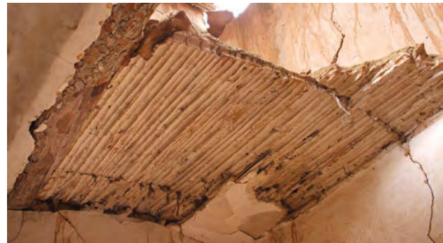
4. Forjado vernáculo de rollizos de pino y revoltón de yeso vertido sobre encofrado de cañas para posterior enlucido en el interior de la provincia de Valencia.
