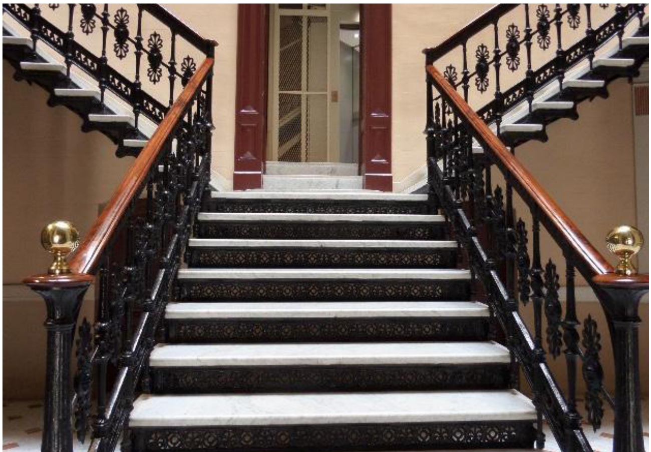
Figuras 1 y 2. Columnas en el interior del Palacio del Marqués de Samá (1868) del arquitecto Josep Oriol Mestres (fotografía extraída de Álvarez, 1874) y escalera principal de la casa Víctor Blajot (1871) de Guastavino (fotografía: N. Luengo).
