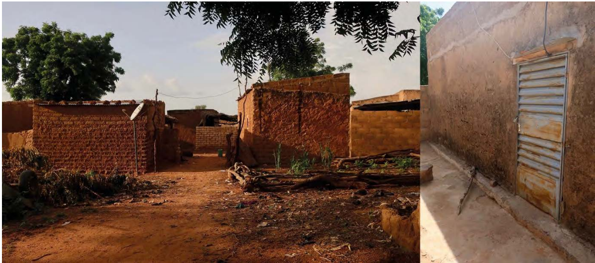
Figura 6. Algunas de las transformaciones, como la ampliación con bloque de cemento, el uso de carpintería metálica o la construcción de cubiertas con chapa metálica ondulada.
