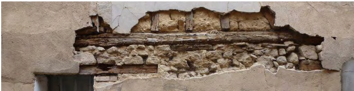
Figura 1. Detalle del muro entramado oculto bajo el revestimiento, en Garganta de la Olla (Cáceres). (crédito: F. V. López-Manzanares, C. Mileto)
