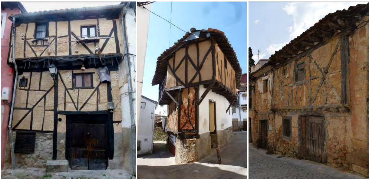
Figura 6. Diferentes ejemplos de muros entramados con presencia de elementos intermedios compuestos. De izquierda a derecha: Cuacos de Yuste (Cáceres), Villanueva de la Vera (Cáceres) y Santo Domingo de Silos (Burgos). (Crédito: F. V. López-Manzanares, C. Mileto)
