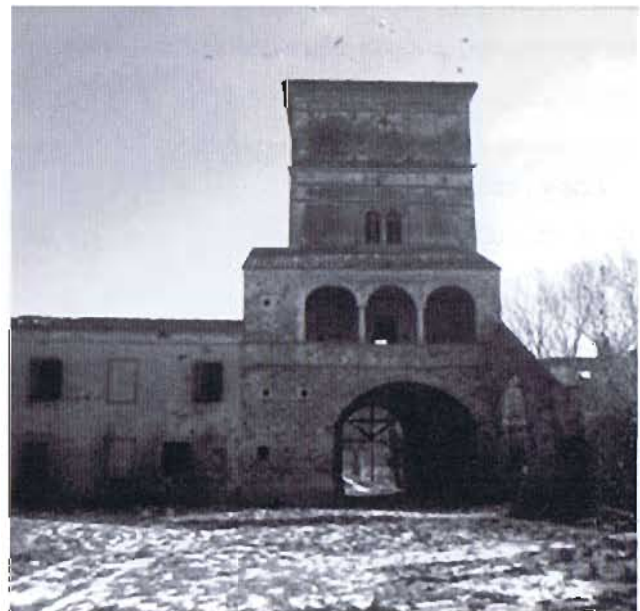
2. Fachada hacia el patio interior de la Villa Paltinieri en Poiana Maggiore, provincia de Vicenza.
