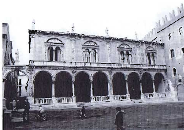
19. Logia del Consejo, construida en Verona por Fra Giocondo a principios del siglo XVI.
