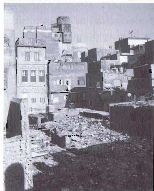
5. Vista de los tejados de las casas del barrio de Wekala Kayetbey-Bab El Nasar .
