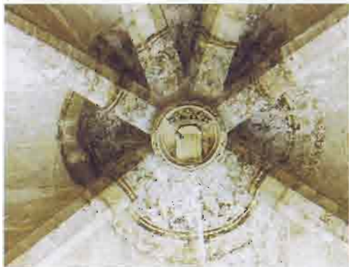
102a Restos de policromía de las dos claves de la nave del nivel medio de la torre de Levante
