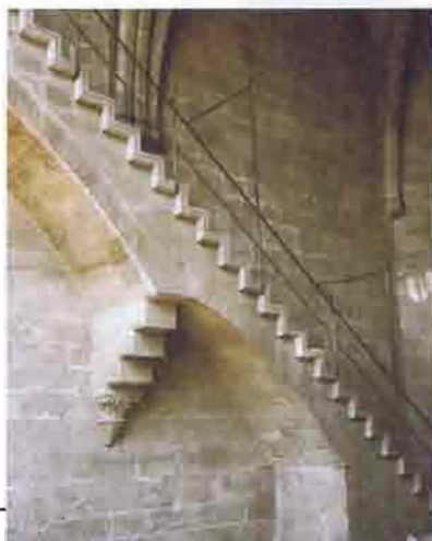
98. Barandilla de la escalera de la nave media de la Torre de Levante
