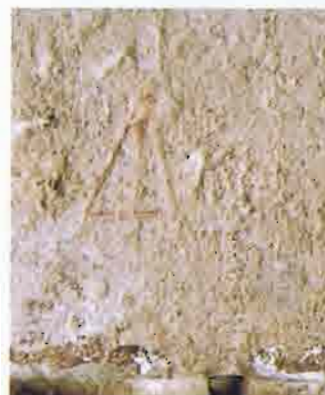
12. Ejemplo de marca de cantería encontrada en los paramentos de las Torres de Serranos. El dibujo fue reforzado con color rojo
