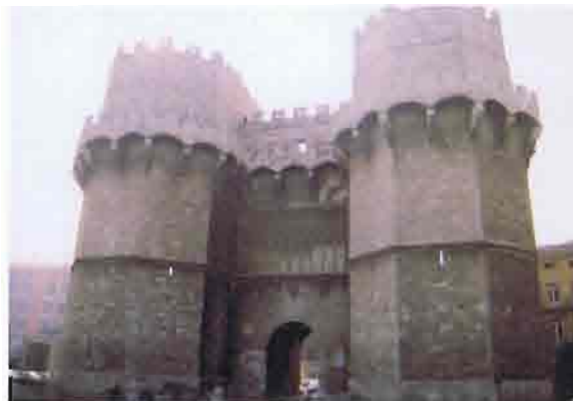
1. Fotografía de la fachada norte de las Torres, antes de la intervención de limpieza (año 2000)
