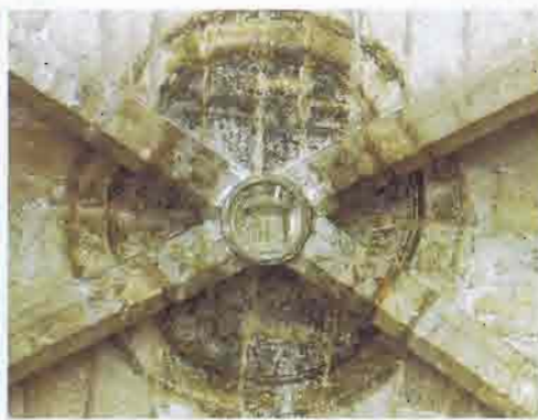
102b. Restos de policromía de las dos claves de la nave del nivel medio de la torre de Levante
