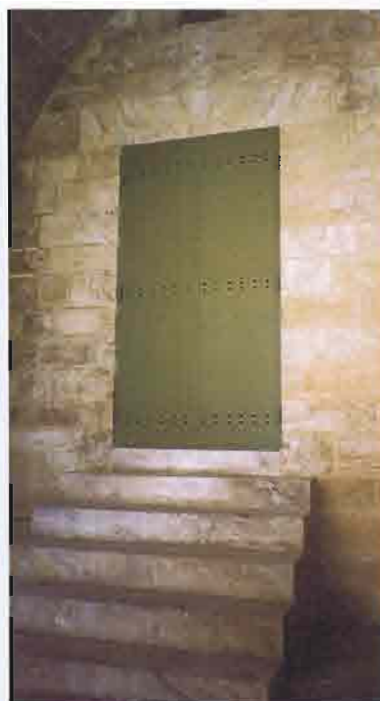
34. Los sillares repuestos que conforman el hueco de la puerta de la parte occidental de la fachada sur
