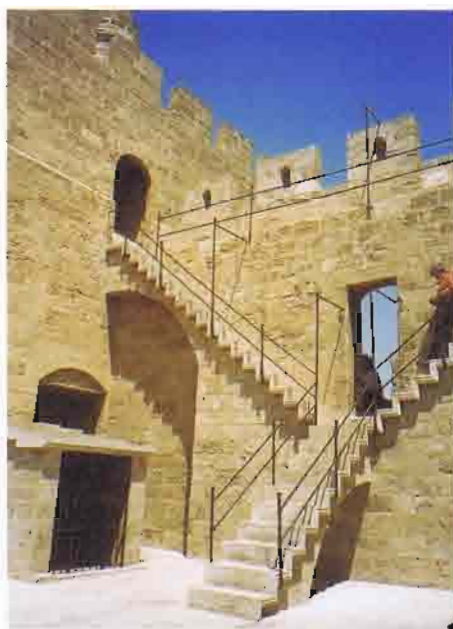
41. Parte de la escalera de ascenso a las terrazas superiores
