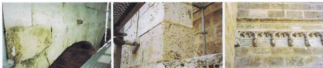
25. Punto donde comenzó la reconstrucción del antepecho del adarve
