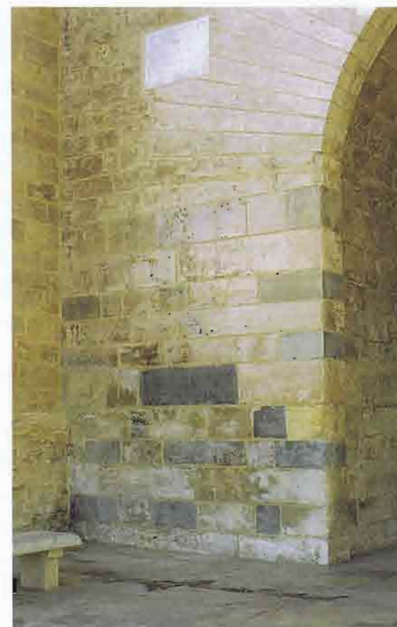
9. Paño de sillares en la base del cuerpo central de la fachada norte
