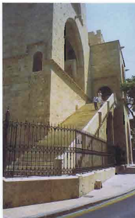
33. La gran escalera reconstruida
