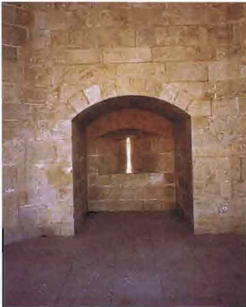
68. Reconstrucción de un nicho y tapiado de la antigua ventana superior
