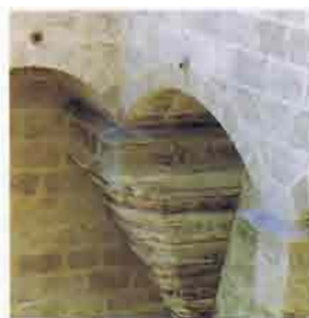
23. Apoyo troncopiramidal del paño central de la fachada norte
