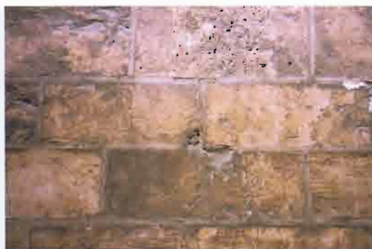
7. Paramento de sillares con coloración rojiza
