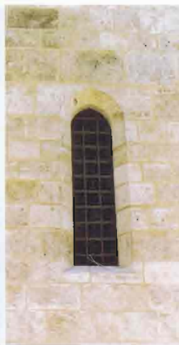
35. Ventana reconstruida de la parte oriental de la fachada sur
