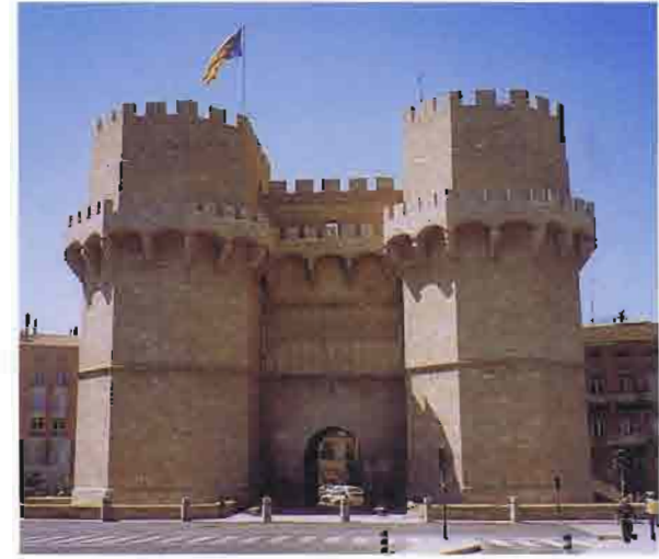
1. Fachada norte de las Torres de Serranos
