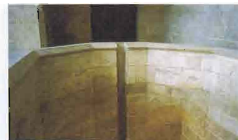
64. Reconstrucción del antepecho en la nave central del primer nivel
