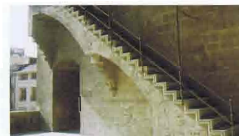
66. Escalera que comunica la nave derecha del primer nivel con la terraza central
