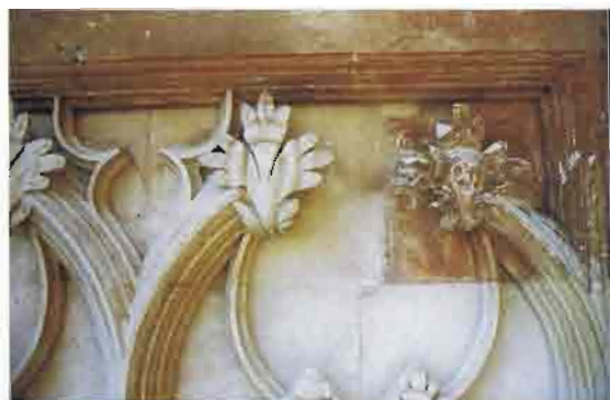
48. Pieza original de la tracería que conserva su color rojo
