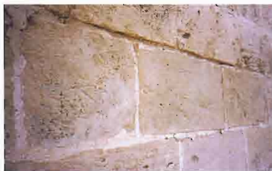
6. Paramento de sillares con marcas de cantería
