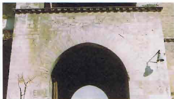
37. Arco de medio punto que define el paso central
