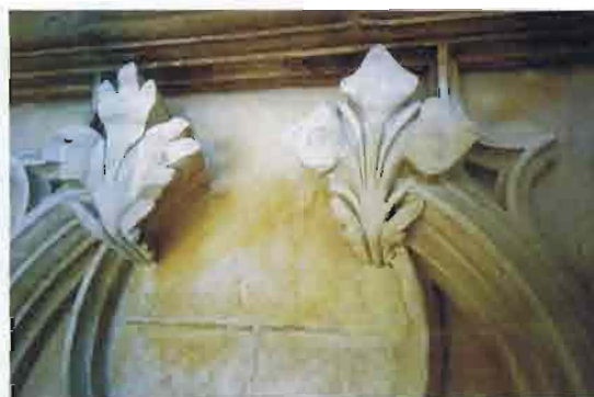
49. Piezas sustituidas de la tracería
