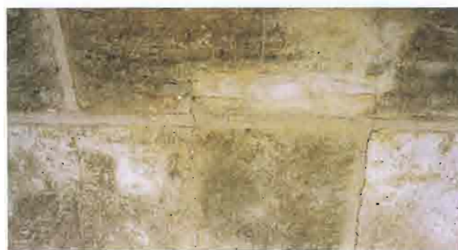
18. Sillar que cierra el mechinal más alto de la hilada
