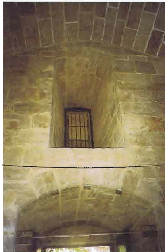
63. Ventana y puerta de la nave izquierda de planta baja
