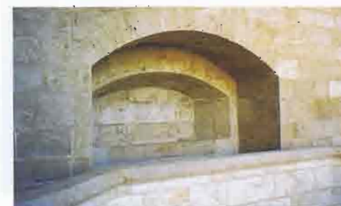
65. Hornacina reconstruida de la nave central del primer nivel
