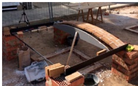
Figura 6. Construcción de la primera hoja de una bóveda tabicada de BTC.
