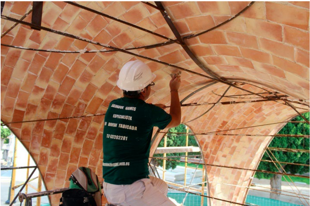
Figura 4. Detalle de la construcción de la bóveda en el que puede apreciarse el despiece de las rasillas.
