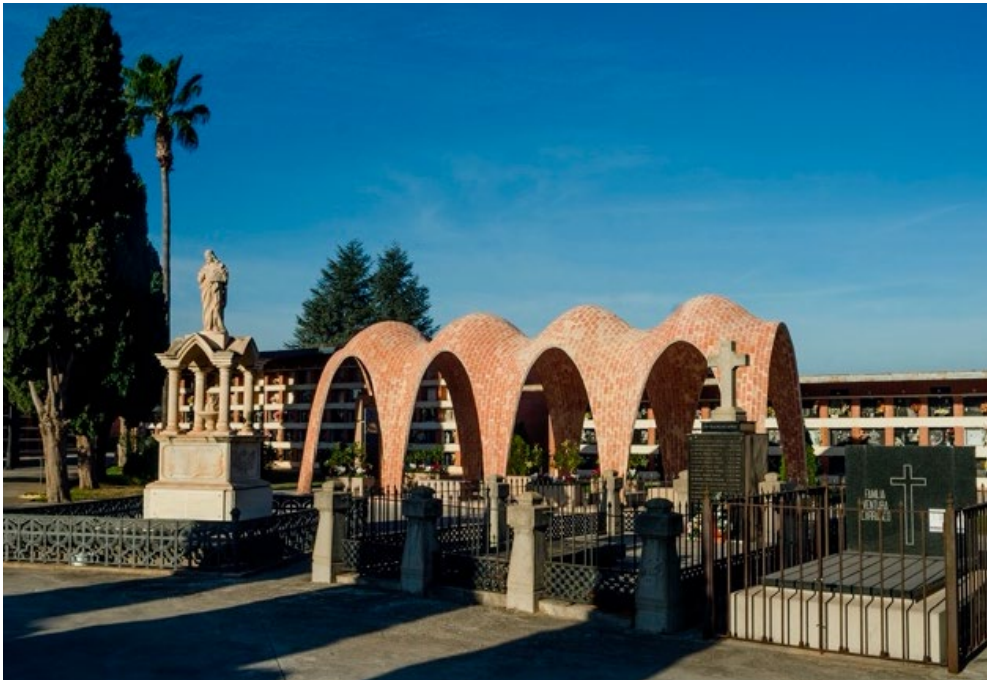
Figura 5. Imagen final de la bóveda tabicada del panteón en el cementerio de Vila-real.
