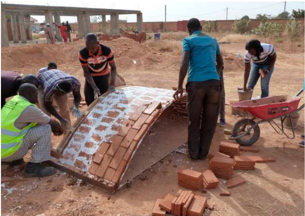
Figura 7. Construcción de las bóvedas tabicadas durante el taller de Ouagadougou.
