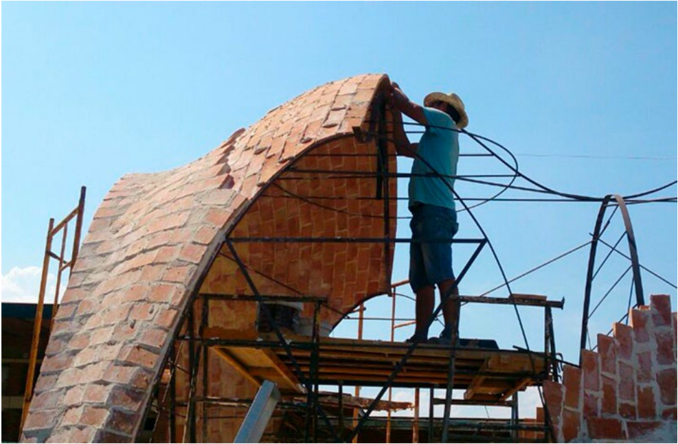
Figura 3. Salvador Gomis durante la ejecución de la bóveda.
