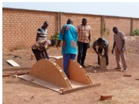
Figura 6. Trazado y construcción de las cimbras de madera durante el taller de Ouagadougou.
