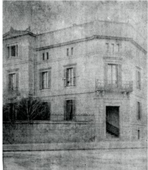
Figura 6. Casa propia de Rafael Guastavino en Barcelona (1872-1875) construida con amplias bóvedas tabicadas recibidas con mortero de cemento Portland importado desde Inglaterra, que cubrían habitaciones enteras (cliché original de Rafael Guastavino, 1881, propiedad de los autores).
