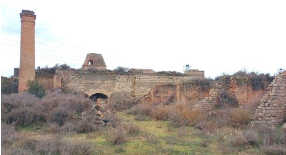
Figura 7. Estado actual de la fábrica de Rafael Montestruc en Almodévar (Huesca), que produjo cemento artificial Portland en la década de 1870 con la ayuda de Rafael Guastavino (Victor Cantero, 2016).
