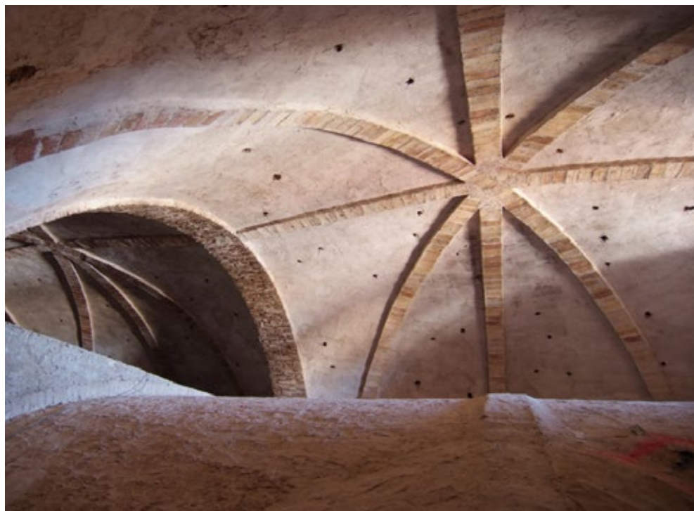
Figura 1. Juan José Nadal emplea exclusivamente el yeso en los arcos formeros de rosca, nervios y primera y sucesivas capas de sus bóvedas tabicadas, como se puede observar en el espacio comprendido entre las bóvedas y el tablero de cubierta de la iglesia parroquial de San Jaime de Vila-Real en Castellón (foto: Tato Baeza, 2009).
