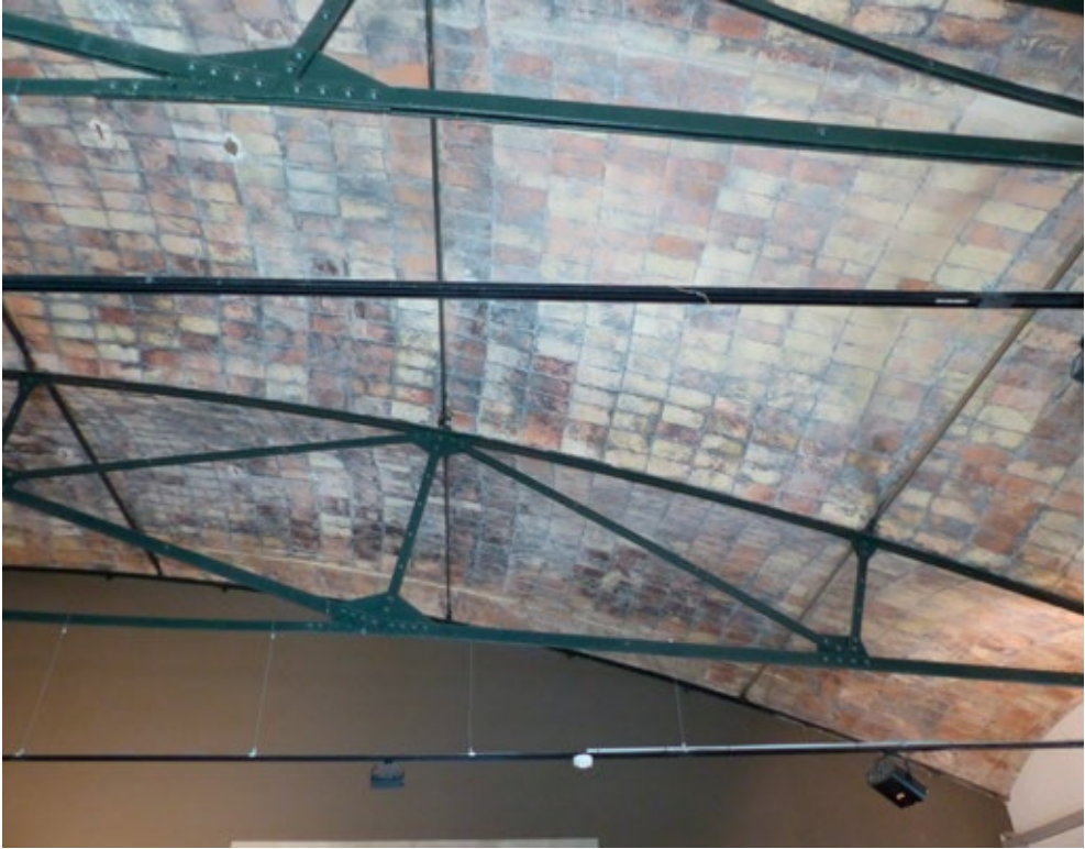
Figuras 8 (pág. anterior) y 9. Bóvedas tabicadas de la fábrica Asland en el Clot del Moro, Castellar de n'Hug, Barcelona, concebida a instancias de la sugerencia y contacto que estableció Rafael Guastavino entre Eusebi Güell y José Francisco Navarro. Diseñada por el mismo Guastavino desde su oficina en Nueva York, se debió construir con cemento fabricado in situ en hornos verticales tradicionales, a la espera de la instalación de los hornos horizontales rotatorios suministrados por la entonces recién creada empresa Allis-Chalmers e importados desde Estados Unidos, que permitieron la producción masiva de cemento artificial Portland en España (Vegas & Mileto, 2018).
